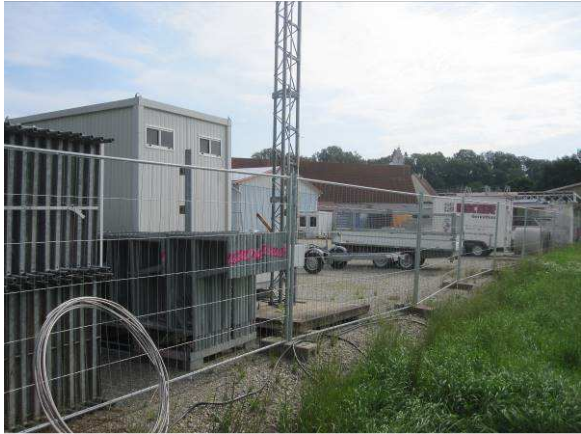
Blick von Süden auf die geschotterte Lagerfläche.
